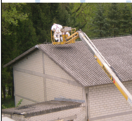
Pripravljalna dela (odstranjevanje strelovoda)
