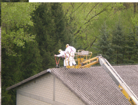
Pripravljalna dela (odstranjevanje strelovoda)
