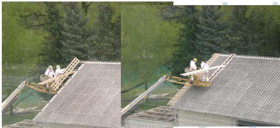
Namestitev pohodnih elementov
